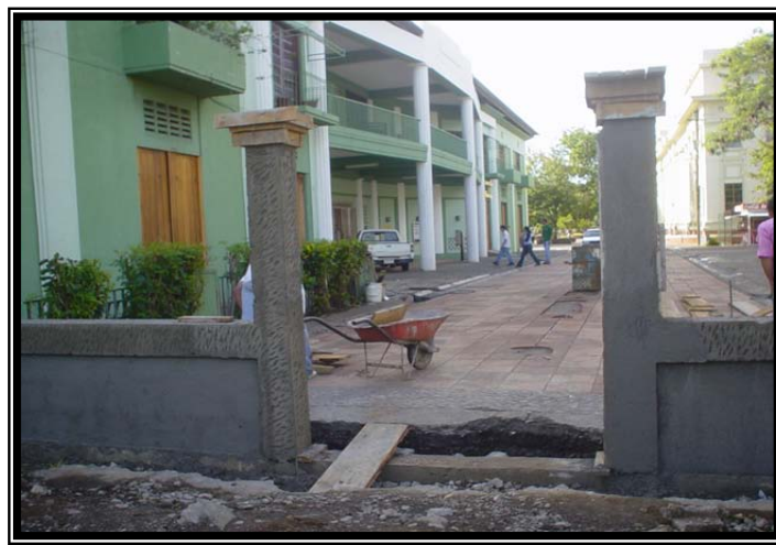
CONSTRUCCION DE MURO PERIMETARAL P.N.C. CCM.
